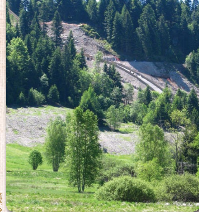
Un tremplin de saut à ski a récemment été construit au-dessus de la tourbière du Grand étang à Gérardmer (88).
